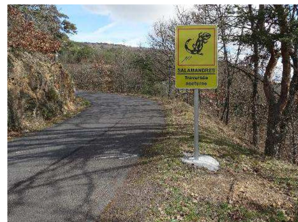
Signalisations routières temporaires à Chaspinhac (43) ©Solenne Muller
